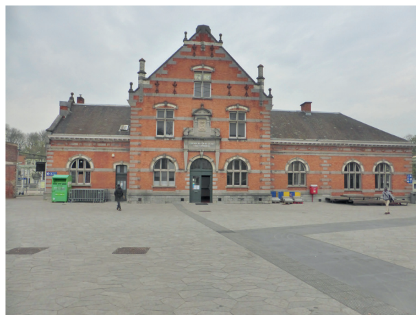
Figure 12 : Le parvis de la gare de Jette a été réaménagé de plain-pied. Cela bénéficie aux PMR, cyclistes et adeptes de la micromobilité. Des bandes de guidage aident les personnes malvoyantes à se repérer.
