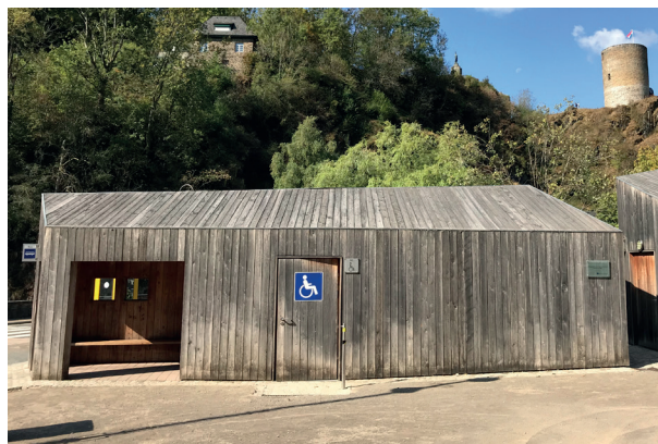
Figure 14 : Le revêtement du parking du pôle bus d'Esch-sur-Sûre est en dolomie. Il est perméable et facilement « mutable ».
