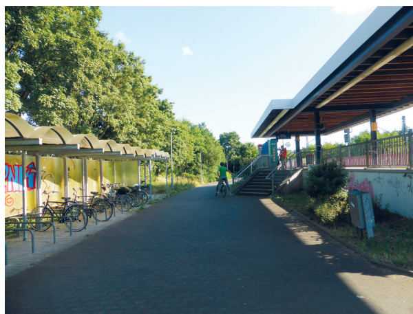
Figure 3 : A cet arrêt de S-Bahn, l'espace à parcourir entre le parking vélo couvert et les quais est minime.
