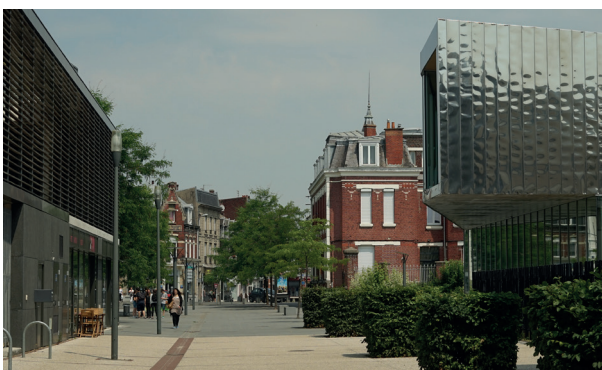
Figures 9 et 10 : La gare d'Armentières a été réaménagée dans le cadre d'une réflexion globale sur le quartier de la gare.
