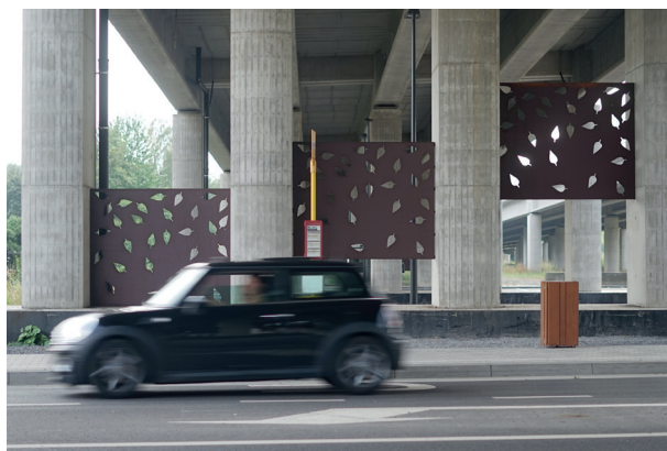
Figure 16 : L'utilisation de l'acier corten et du bois confère une ambiance chaleureuse à cette aire de covoiturage localisée en dessous d'un pont d'autoroute (Bassenge).
