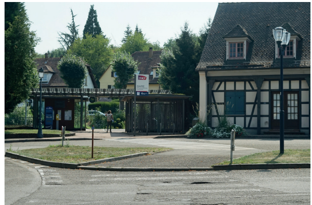
Figure 11 : La halte éco-modulaire de Niederbronn-les-Bains intègre des panneaux photovoltaïques ainsi qu'un système de récupération des eaux de pluie.
