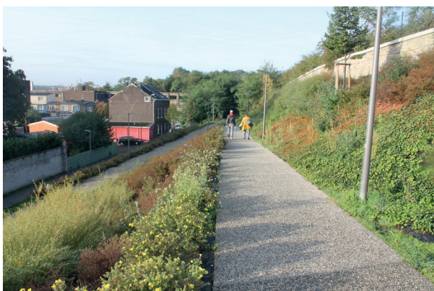
Figure 4 : Un cheminement en pente-douce a été aménagé pour accéder aux quais de la gare d'Herstal.
