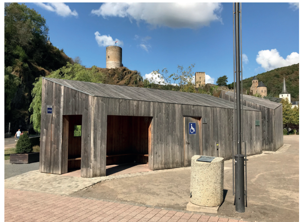
Figure 12 : Le pôle bus d'Esch-sur-Sûre intègre une aire de pique-nique, un espace protégé des intempéries ainsi que des sanitaires qui sont ouverts et fermés quotidiennement par des employés communaux.
