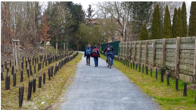
Dans la Région des Hauts-de-France, la Communauté d'agglomération du Douaisis utilise un stabilisé renforcé par un liant végétal permettant à la fois une certaine pérennité du revêtement et une perméabilité aux eaux pluviales. Ce revêtement est utilisé comme support pour le réseau de voies lentes. Crédit photo : Douaisis Agglo
