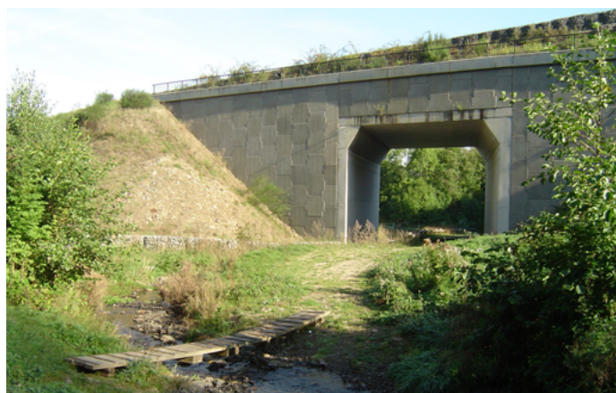
Lors du chantier de la liaison Tihange-Strée (N684), un passage a été créé pour le ruisseau du Morrisart. Le dimensionnement de ce passage permet également son utilisation par les randonneurs et par les animaux, y compris les grands mammifères. Crédit photo : S. Hendrickx
