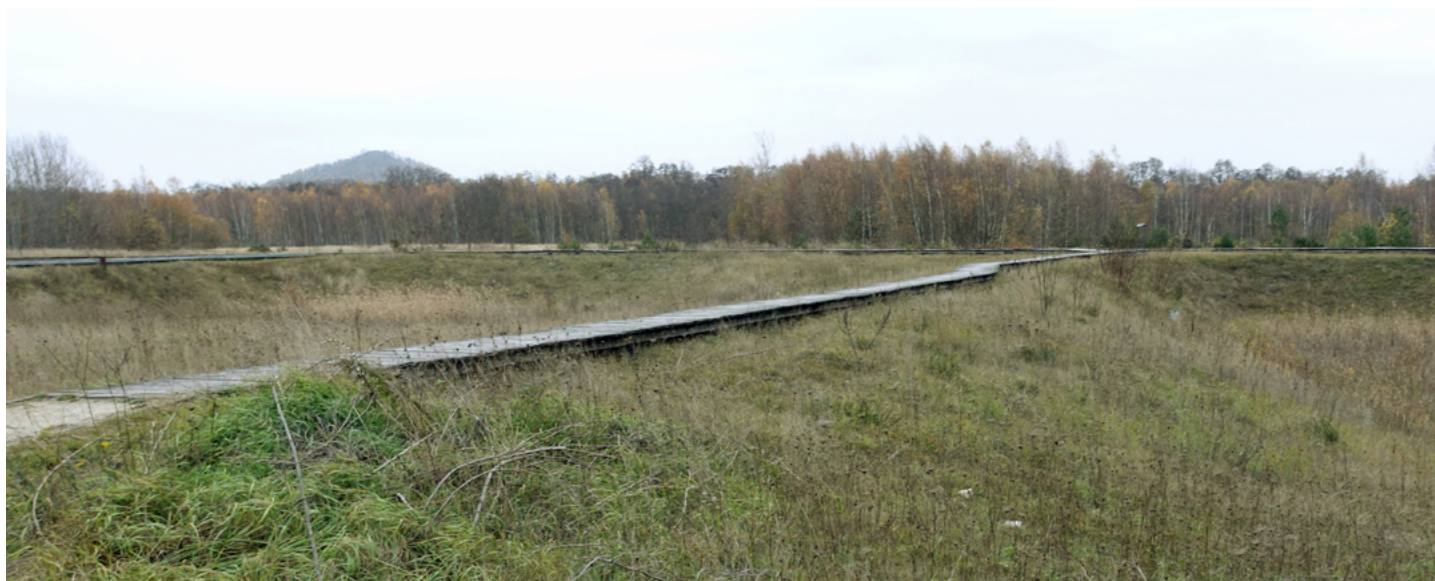
A Genk, le Thor Park, un projet de réaffectation de friches minières situées en zone de démergement, compense l'imperméabilisation des sols à la suite de l'installation d'entreprises par la création de bassins de tamponnement. Les bords de ces bassins permettent la mobilité douce, dans ce qui est devenu un des plus grands espaces verts de la ville.
