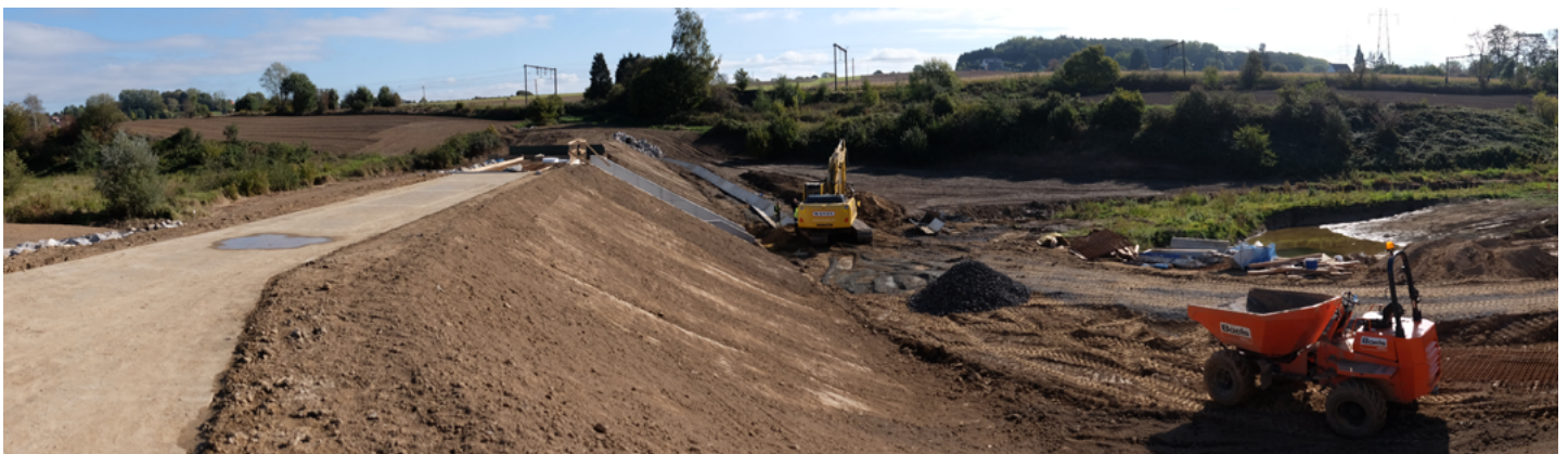
La zone d'immersion temporaire de Coeurcq (Tubize), ici en construction, constitue un des nombreux aménagements prévus par le projet LIFE IP BELINI dans le bassin de la Senne. Si l'objectif principal est d'améliorer la gestion des eaux, le projet ambitionne également d'augmenter la délivrance d'autres services écosystémiques. Crédit photo : A. Coppens
