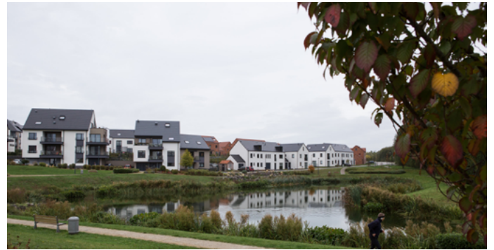
Bassin d'orage paysager et cheminements imposés au promoteur dans le cadre de la mise en œuvre de la ZACC du Petit Baulers (Nivelles). Crédit photo : G. Dardenne
