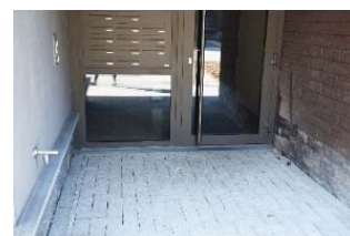
Figure 6 : logement accessible sans marche, ni ressaut.
