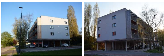
Figure 7 : ce bâtiment construit sur pilotis offre 12 logements adaptables. Cette configuration permet aux PMR de garer leur véhicule au plus près de leur logement et d'y accéder aisément via un ascenseur
