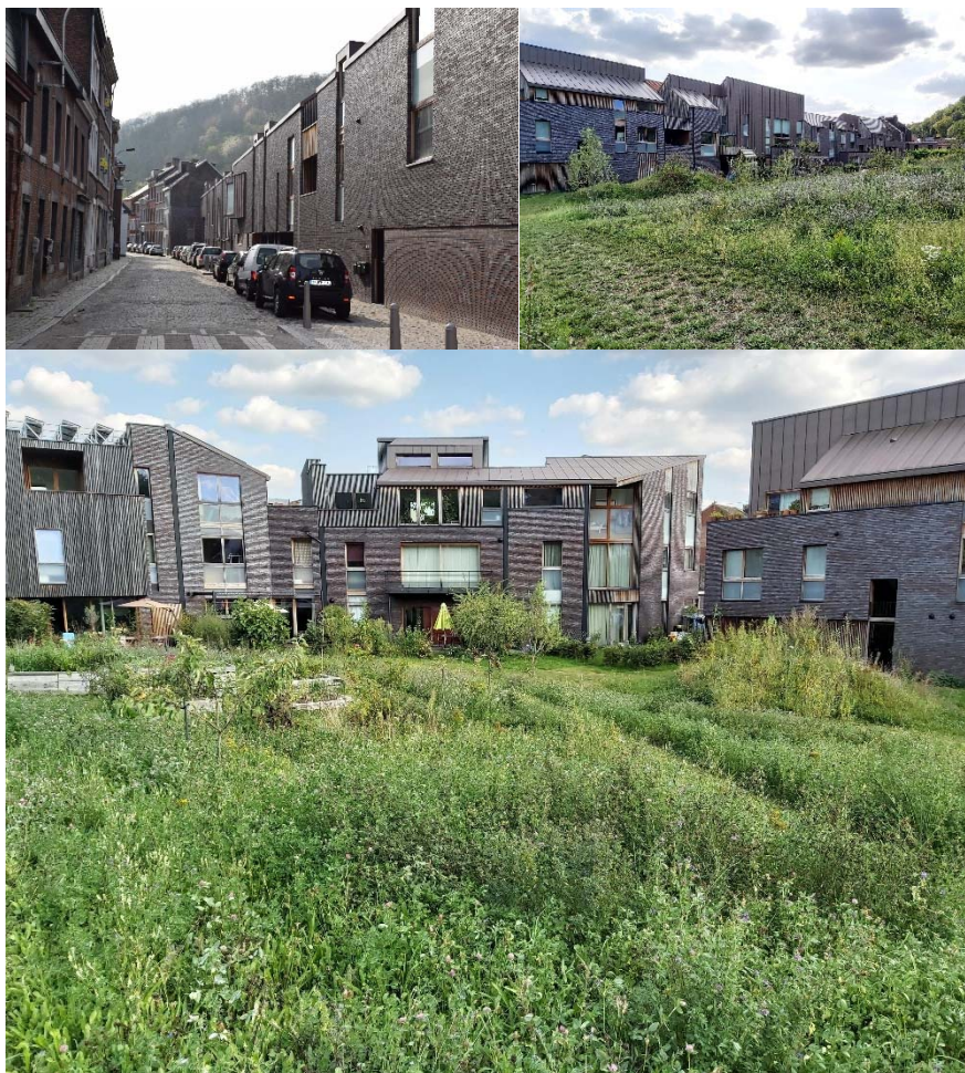
Figure 3 : Habitat groupé Les Zurbains à Liège
