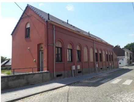
Figure 5 : Habitat groupé intergénérationnel à Chièvres (Source image : https://www.habitat-groupe.be )
