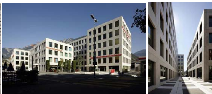
MeZ et BGS, un ensemble urbain dense et architecturalement cohérent
