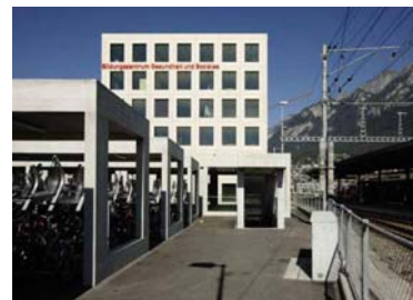
Intégration des abris vélos dans la composition d'ensemble
