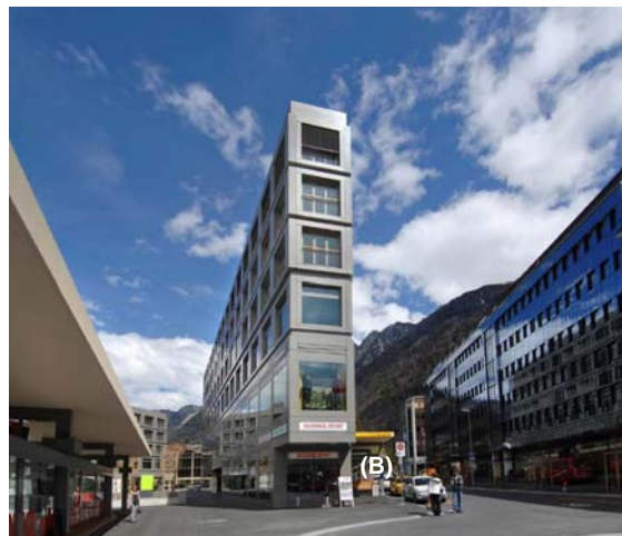
Bureaux et logements intégrant la rampe pour vélos (B)
