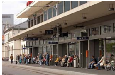
Nouvelle gare avec bancs intégrés
