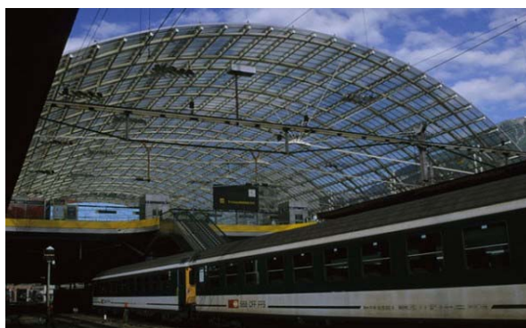
Vue sur la halle vitrée des bus (niveau des quais)
