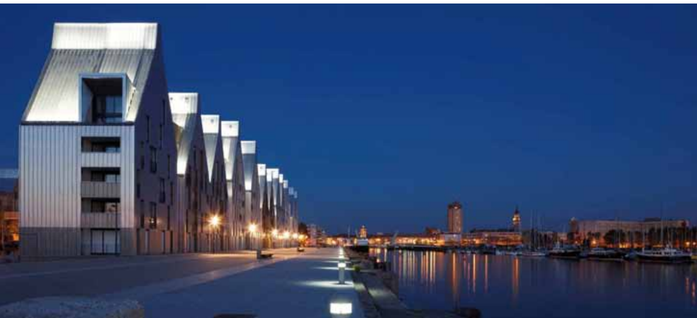
Les Gâbles, vers le centre ville : éclairage nocturne
