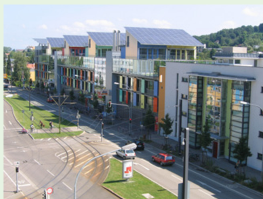
Vue du quartier Vauban, à Freiburg im Breisgau (Allemagne). Intermodalité des déplacements dans l'espace public (tram, vélos, piétons, voiture), tram en site propre perméable pour l'infiltration de l'eau de pluie, panneaux solaires sur les toitures. © Florence Léonard
