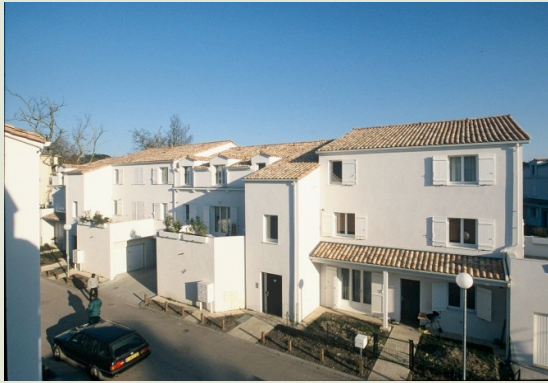
Logements sociaux (Domofrance), Mérignac 2001
