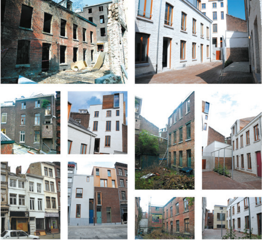
Îlots Firquet / avant & après travaux © Ville de Liège
