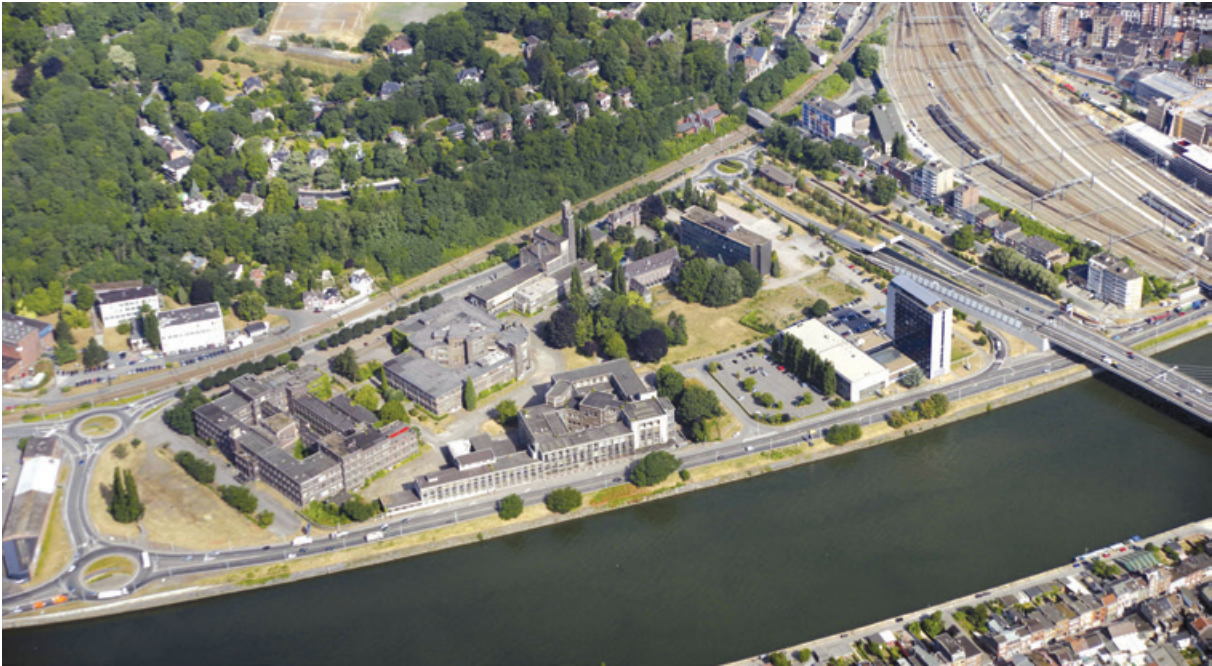
Vue aérienne - © Baumans-Deffet sprl
