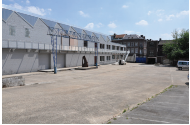
Vivegnis RAVI / après travaux - © Ville de Liège
