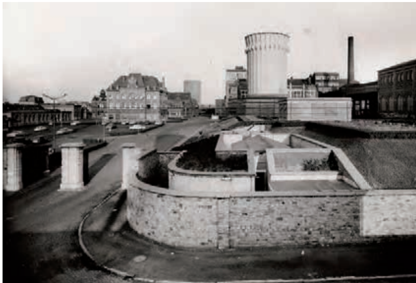
Vue depuis la belle fleur du puits « Numéro 2 ».
