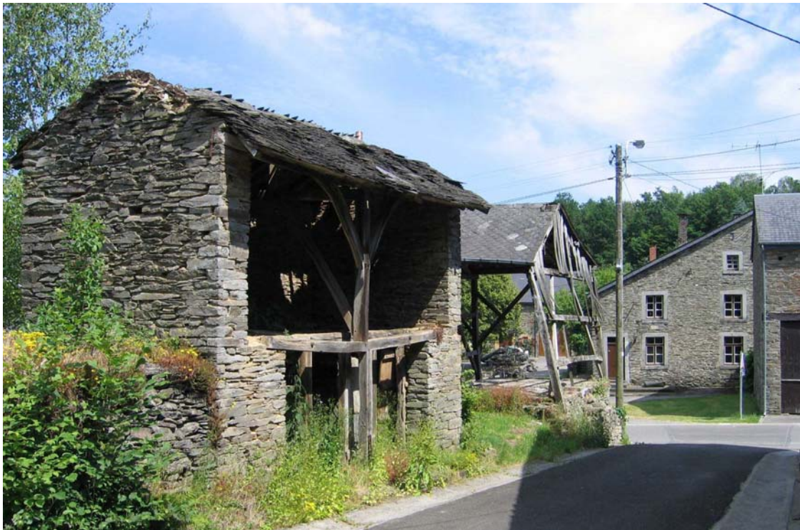
Les volumes élancés des séchoirs à tabac construits à la hâte dans la fièvre de l'« or vert », caractérisent encore le paysage. L'habitat traditionnel en schiste local se voit confronté au bois.
