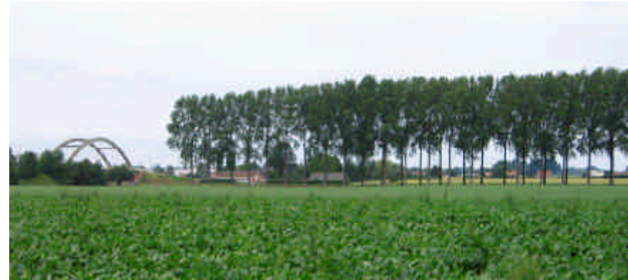
Pont sur le canal de l'Espierres
