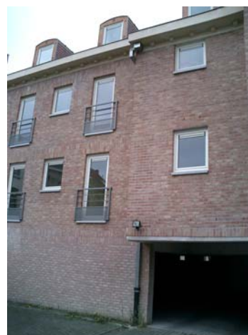
Photo 2 : Façade arrière et entrée parking souterrain
