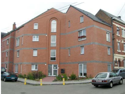
Photo 1 : Bâtiment sur le coin
