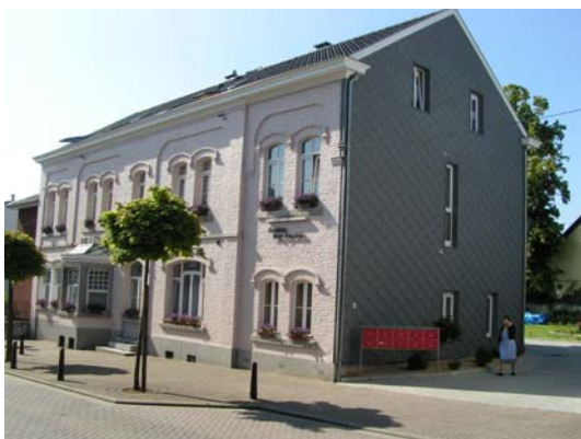
Photo 1 : Façade à rue
