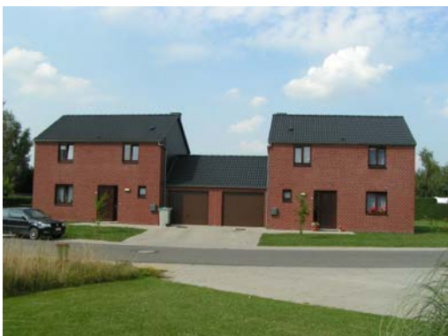
Photo 1 : Bloc de 2 maisons
