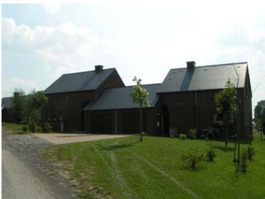
Photo 1 : Bloc de 2 maisons
