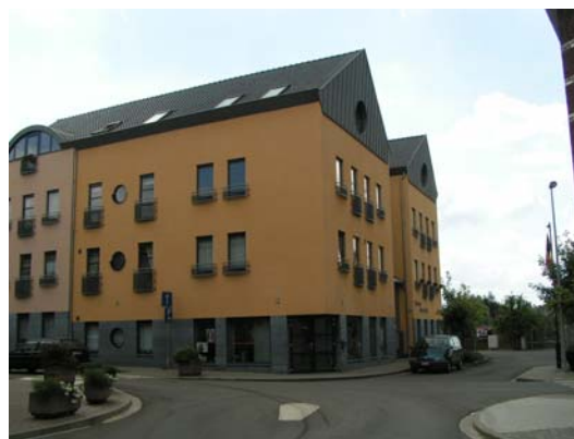
Photo 2 : Vue de côté
