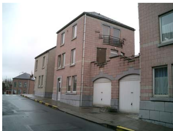
Photo 2 : Maisons et garages
