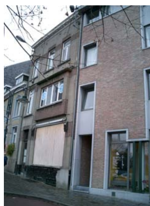
Photo 2 : Maison voisine (problème de stabilité)
