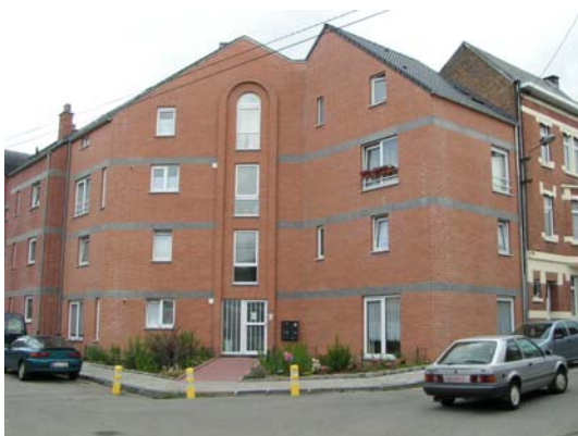
Photo 1 : Bâtiment sur le coin
