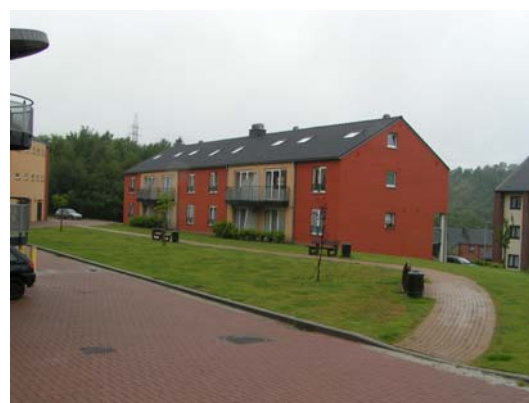
Photo 4 : Abords et piétonnier
