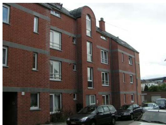
Photo 2 : Bâtiment rue Piret Pauchet
