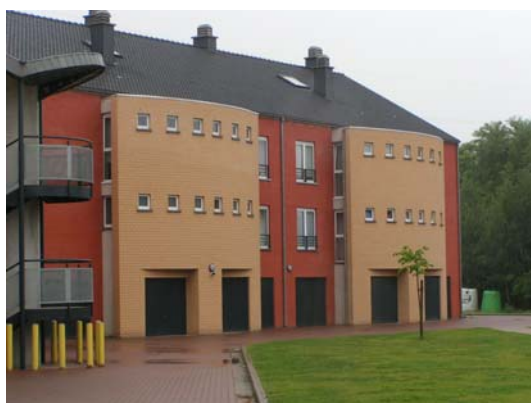
Photo 3 : Arrière du bâtiment n°1
