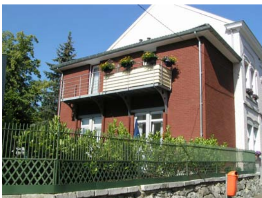
Photo 3 : Bâtiment latéral et balcon
