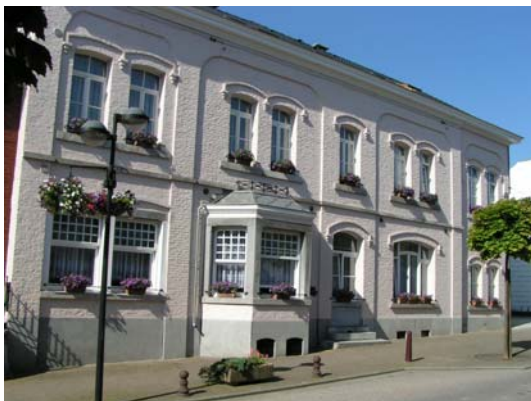
Photo 1 : Façade à rue
