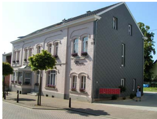
Photo 2 : Façade à rue
