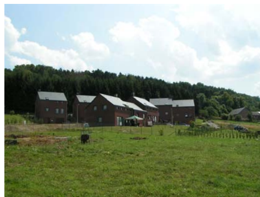
Photo 4 : Partie haute du lotissement
