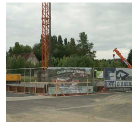
4. Site en construction
