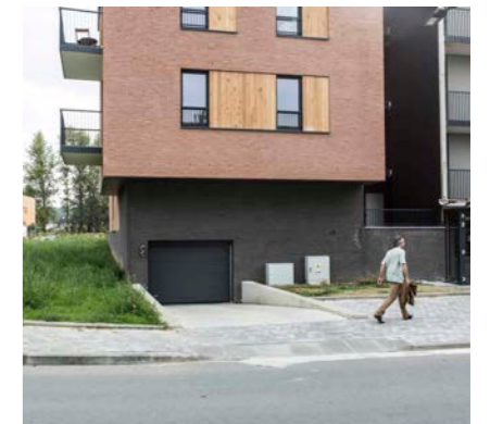
9. Accès au parking souterrain sous un logement
