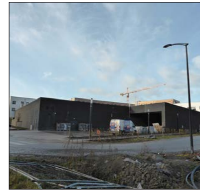
4. Façades arrières des commerces peu qualitatives
