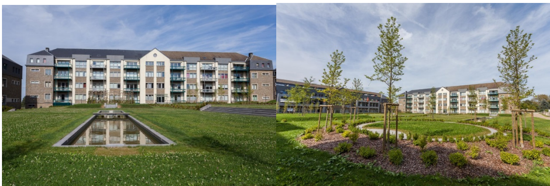
Figure 76 - photos des casernes de Callemeyn - Sources : A3 Architecture
