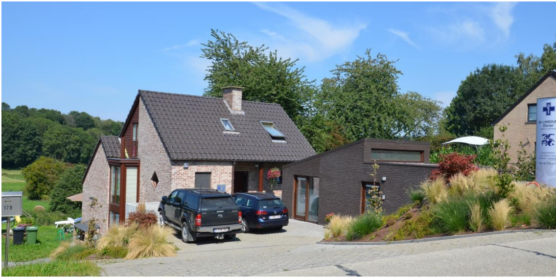
Figure 15 : Anthisnes, Chaussée de Liège
