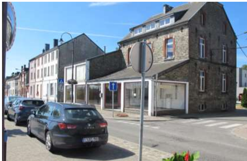
Photo 18 : Bâti en état correct, malgré quelques cellules vides.
