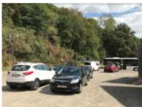
Figure 16. « Le revêtement du parking est en cobble. Il est perméable et facilement « mutable ».
