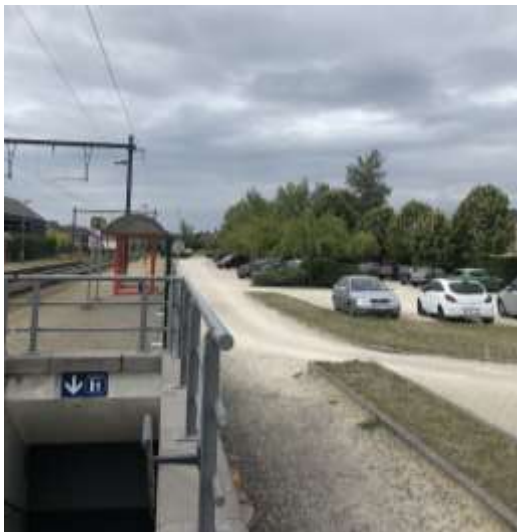
Figure 1 : Passage souterrain permettant de franchir les voies de chemin de fer.
