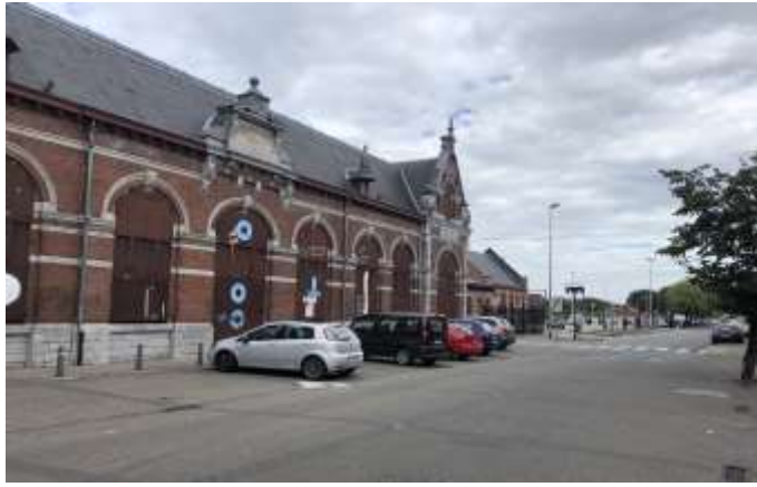
Figure 5. La voirie est configurée en espace partagé de plein pied.
