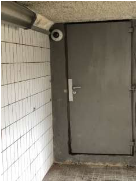
Figure 3. Le passage souterrain est doté d'un éclairage et d'une caméra de surveillance.
