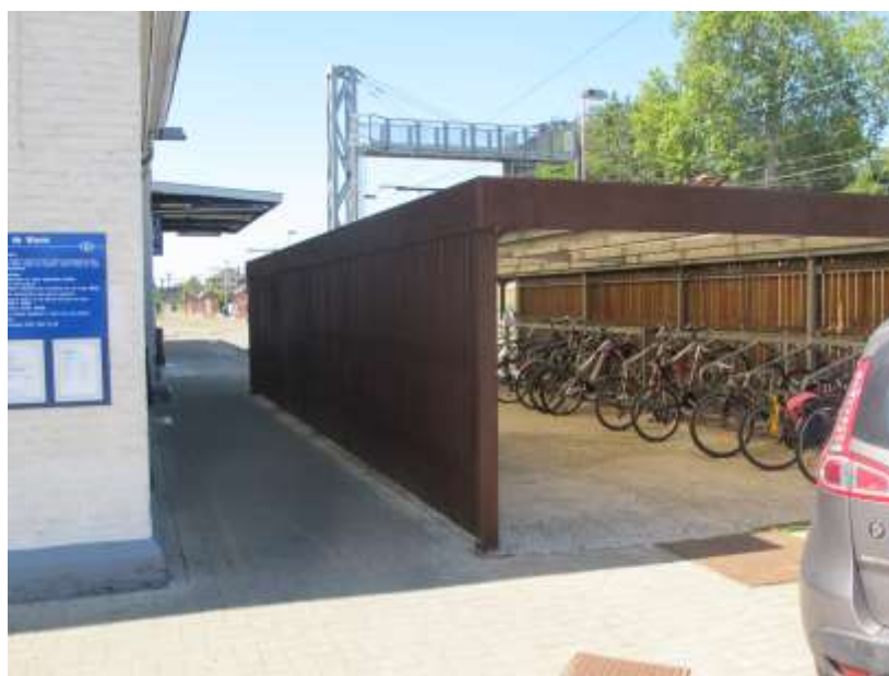
Figure 9 : Abri à vélos.
