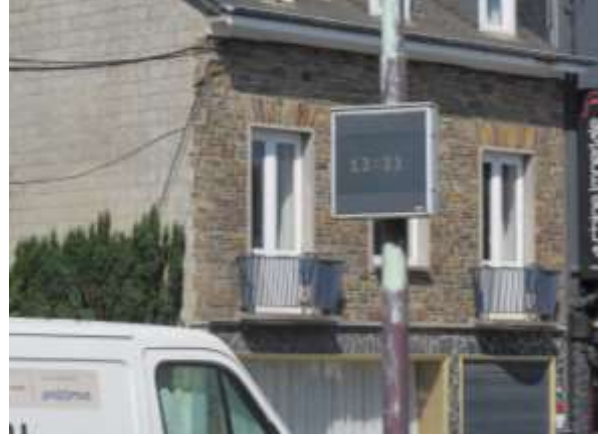
Photo 6 : Écran informatif défaillant.
