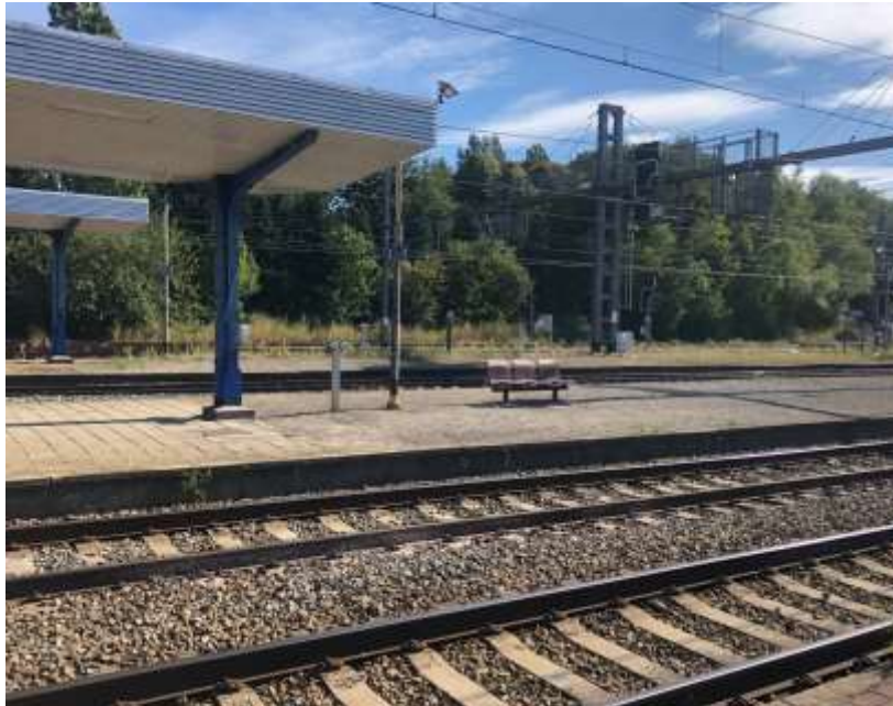
Figure 3 : Les espaces d'attente sur les quais sont minimes.
