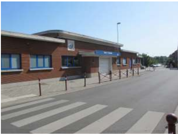
Figure 12. Le bâtiment est actuellement en bon état.
