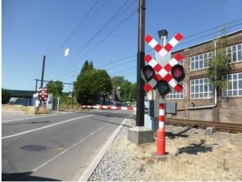
Figure 2. Le passage à niveau constitue un obstacle aux cheminements.
