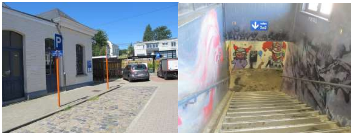
Figure 8 : Passage sur le côté du bâtiment et passage sous voies.
