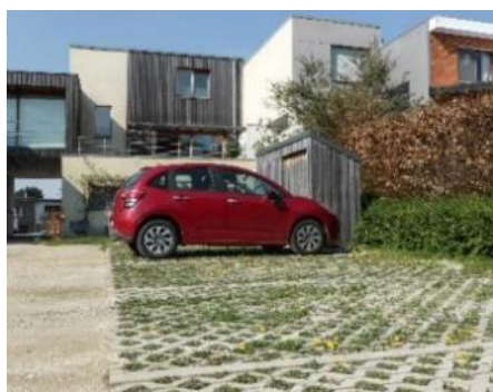
Place de stationnement sur dalle enherbée sur domaine privé dans un projet de logement à Tilleur.
