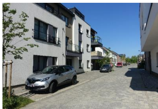
Aménagement de place de stationnement en voirie de plain-pied dans le projet du 'Petit Bailleurs' à Nivelles
