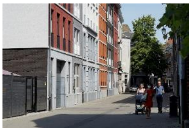
Immeubles d'appartements intégrés dans un contexte de maisons mitoyennes au centre de Namur
