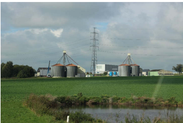
Figure 14. Silos de stockage verticaux. Entreprises SCAM à gauche et Brichart (Wal.Agri) à droite, Les Isnes (Crédit photographique : Bruggeman).
