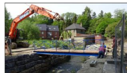
Pose de la passerelle cyclo-piétonne
