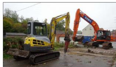
Enlèvement du pont
