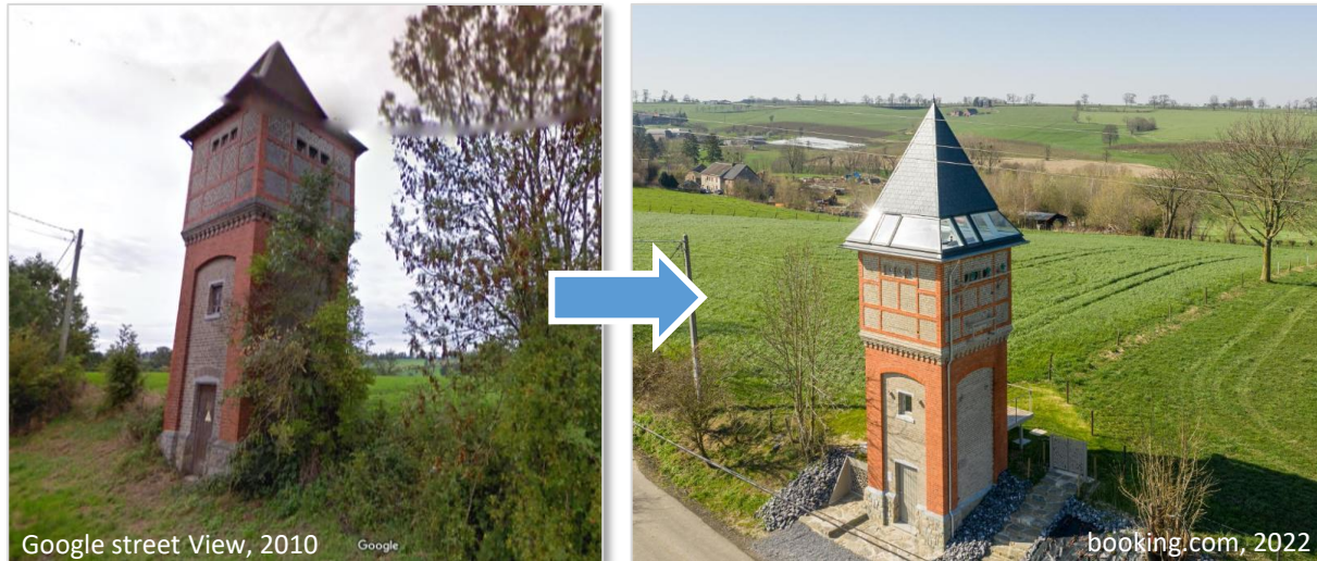
Herve : Ancienne tour électrique (1930) devenue logement insolite
